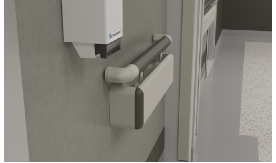
Duvar Yüzeyleri Wall Surfaces
